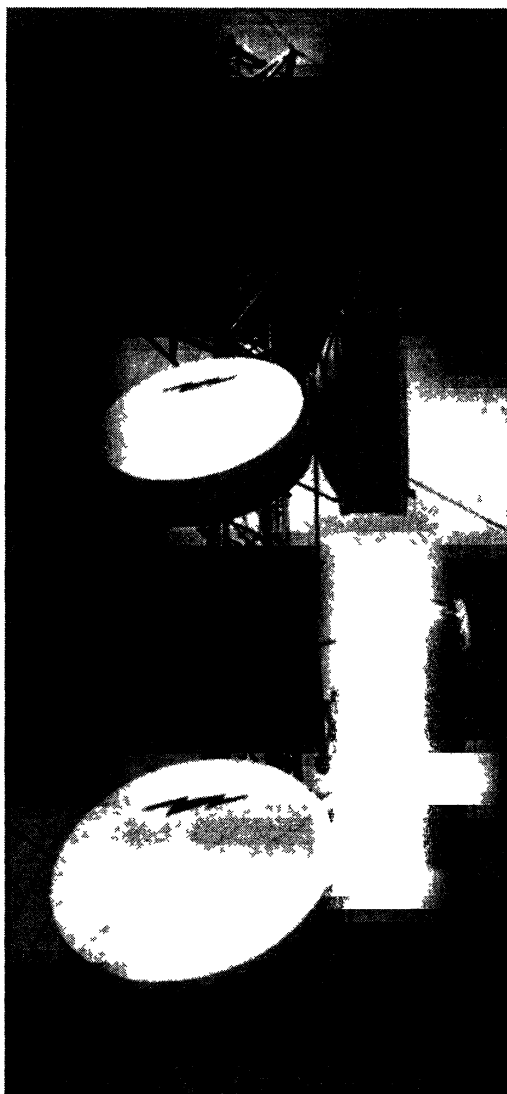
Рис 34 8 Мачта с параболическими антеннами, защищенными от атмосферных воздействий
