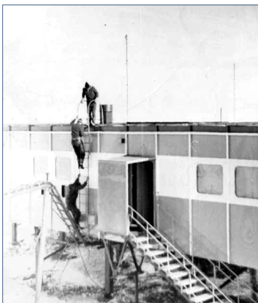
Ремонт вертикала 4K1A на помещении приёмного радиоцентра.
