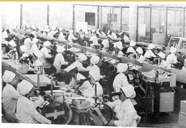
УЧАСТОК ПРИСОЕДИНЕНИЯ КРИСТАЛЛОВ И ПРОВОЛОЧНЫХ ВЫВОДОВ НА УСТАНОВКАХ ЭМ-409, ЭМ-410
