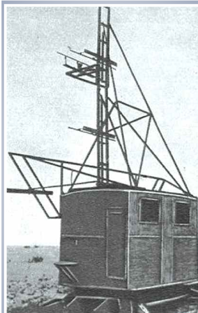
Излучающая установка станции СОН-2.
