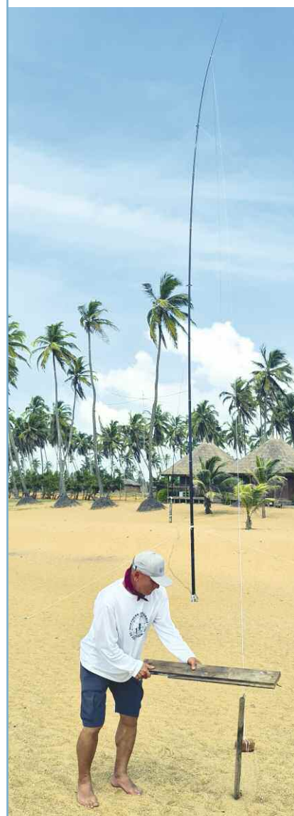
Установка 18-метровой антенны GP на диапазон 160 метров.
